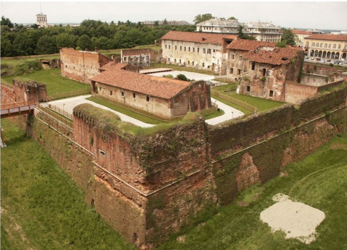
Foto 6, Angolo Sud Est prima del restauro.
