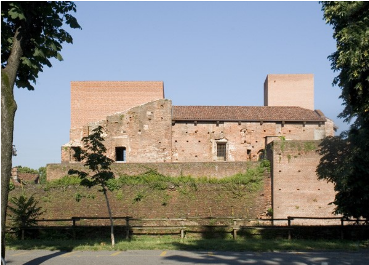
Foto 8, Ala Ovest , interessata ancor oggi dai lavori di restauro.
