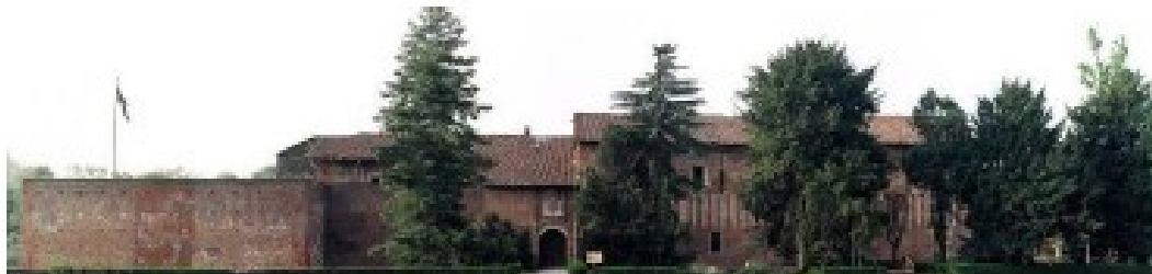
Foto 1, Facciata Nord prima degli interventi di restauro del 2007.
