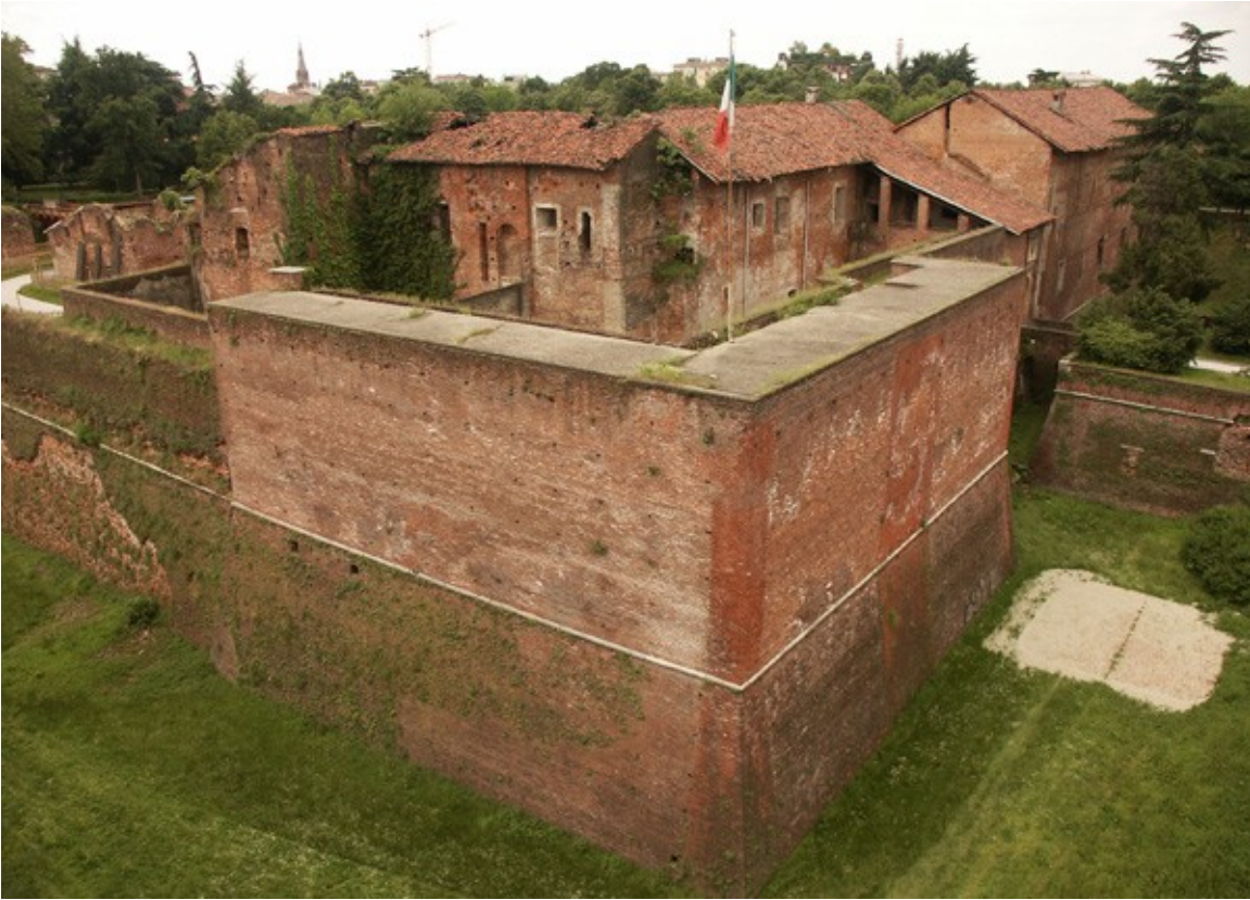
Foto 3, Angolo Nord Est prima del restauro.
