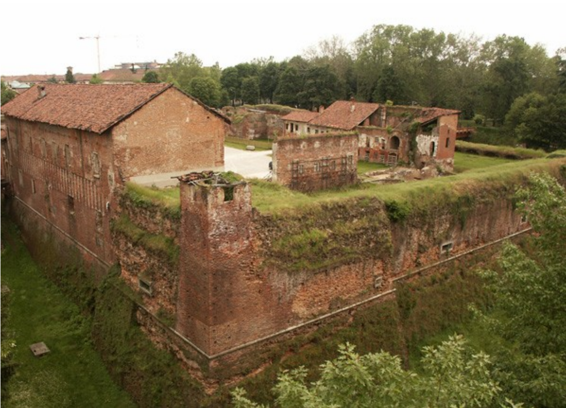
Foto 4, Angolo Nord Ovest prima del restauro.
