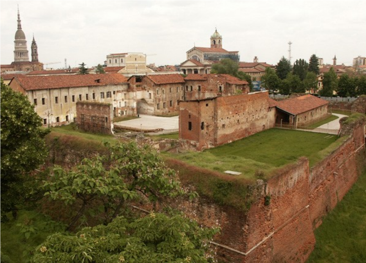
Foto 5, Angolo Sud Est prima del restauro.
