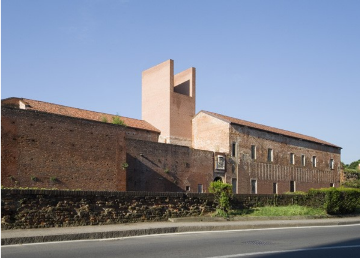
Foto 7, Facciata Nord interessata da restauro con torre aggiunta nel 2007.
