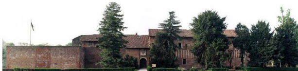
Novara. Il corpo di facciata (orientato a nord) della rocca visconteo-sforzesca prima degli interventi di "restauro" avviati dall'Amministrazione Comunale.
